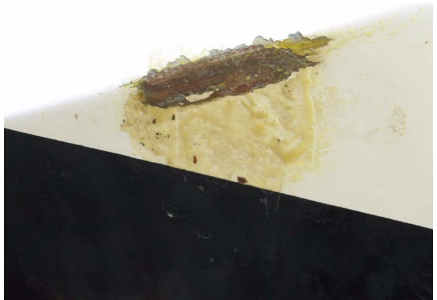
Zum Glück nur geringfügige Schäden (hier nach erster Hilfe)
